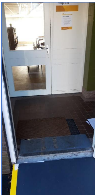
Gesloten deur binnen met te kleine vrije ruimte
