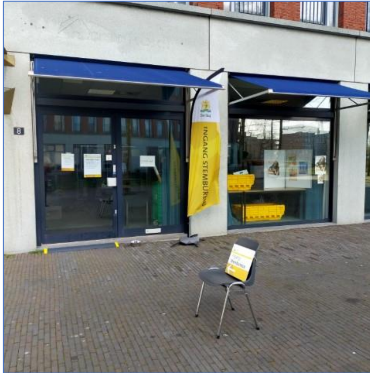
Gevel voorziende Inclusion4all. Het deurkozijn heeft dezelfde kleur als het raamkozijn en is daardoor moeilijk te herkennen.
