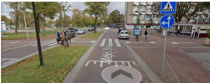
Voetgangersoversteekpunt met markering met geleidelijn
