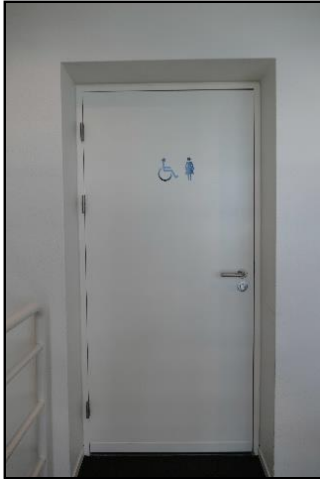
Toegangsdeur tot toilet
