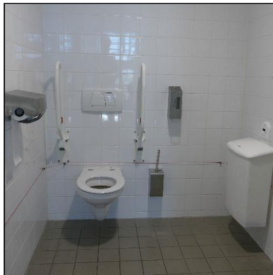
Totaaloverzicht van de toiletruimte
