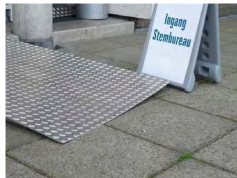
Gevaarlijke situatie door kromgetrokken ijzeren plaat, struikelgevaar
