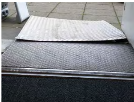
Gevaarlijke situatie door kromgetrokken ijzeren plaat, struikelgevaar
