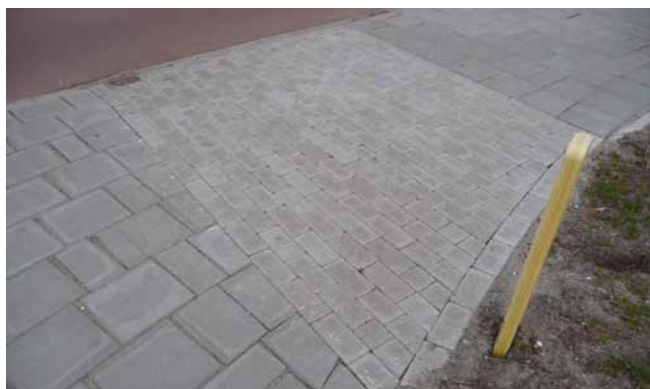
Detail: strook in het trottoir
