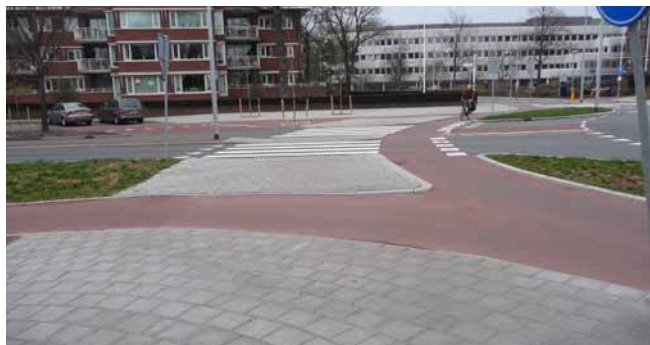
Op deze rotonde kan een blinde voetganger het zebraapad niet vinden
