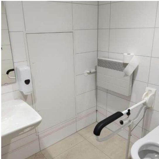
Ruimte naast de toiletpot is voldoende
