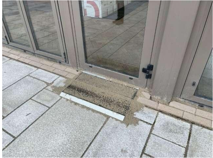
De te overbruggen ruimte tussen pand en bestrating is opgevuld met klinkers. Daaroverheen ligt een drempelhulp.
