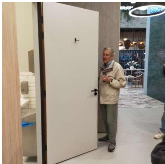
Binnenzijde deur gehandicaptentoilet, horizontale beugel ontbreekt.
