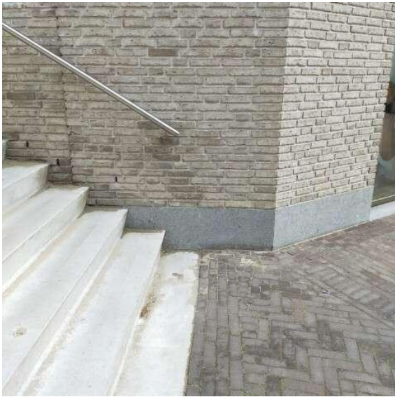
Alle foto's: Betonnen trap zonder contrastmarkering en met te korte leuning.
