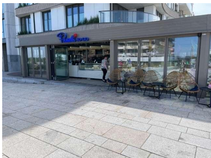
Bij de ijsverkoop (Pavarotti) is de aansluiting tussen het pand en de buitenruimte schuin aangelegd.
