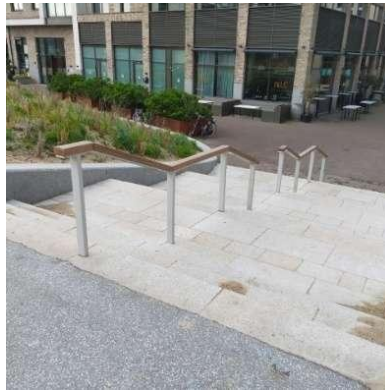
Drie foto's: trappen van natuursteen zonder contrastmarkering. Houten leuning loopt niet door bij het tussenbordes en is aan de onderzijde niet horizontaal.
