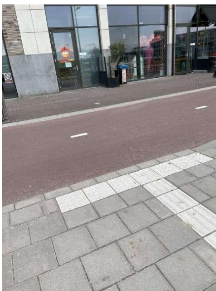
Aanlijning van het zebrapad, maar niet op het trottoirgedeelte aan de gevelzijde
