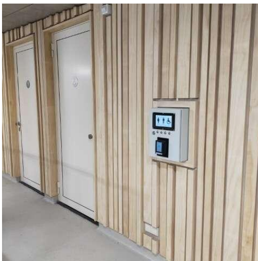
Buitenzijde toiletdeur met rolstoelbordje. Daarnaast de betaalautomaat om het toiletbezoek te betalen.
