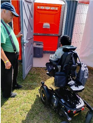
Toegankelijk toilet zonder beugels en zonder de juiste maatvoering.
