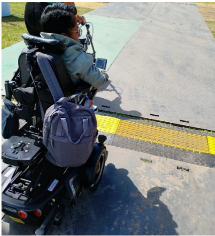
Kabelgoot geplaatst tussen de rijplaten met weinig hoogteverschil.
