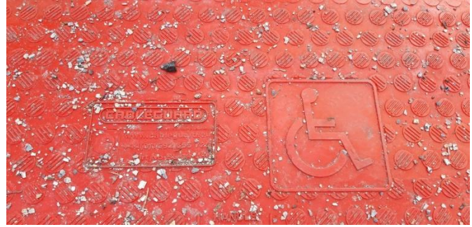
Rolstoeltoegankelijke kabelgoot.
