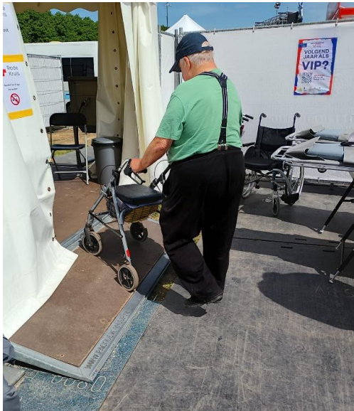
De helling om de EHBO binnen te komen was te steil voor mensen met een hulpmiddel.
