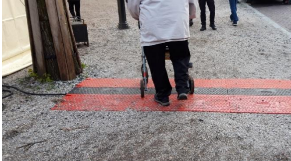
Rolstoeltoegankelijke kabelgoot.
