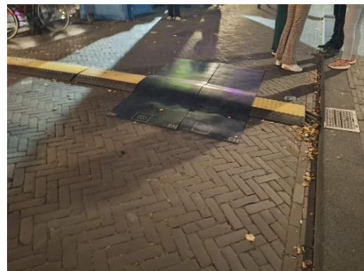
Kabelgoten met daaroverheen kabelmatten in het middengedeelte en haaks op de looproute.
