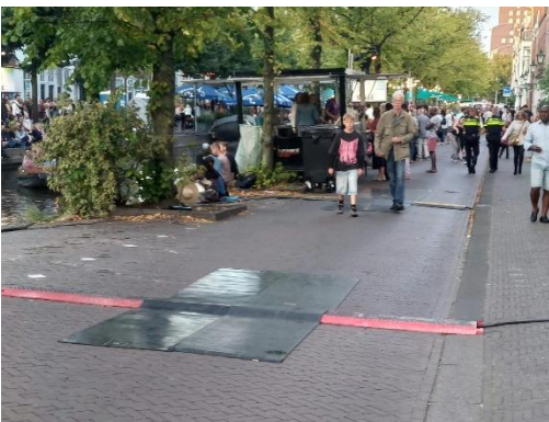
Kabelgoten met daaroverheen kabelmatten in het middengedeelte en haaks op de looproute.
