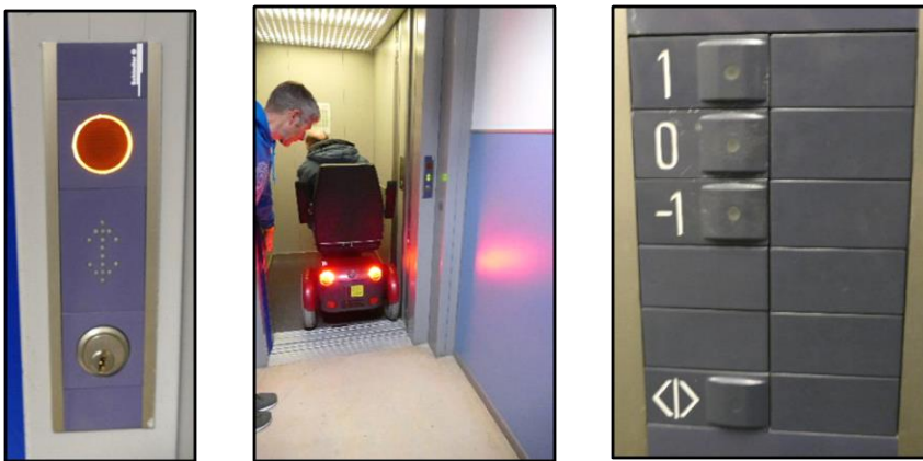
Oproepknop met slot, entree tot de lift en paneel ín de lift
