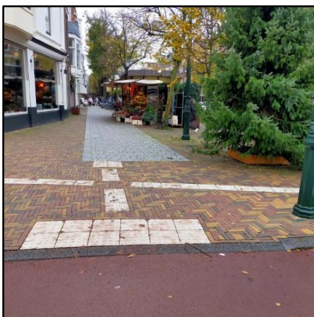
Schuine band loopt door bij de oversteek Hoogteverschil 5cm
