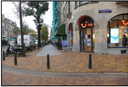
'Vergevingsgezinde' trottoirbanden op de hoeken
