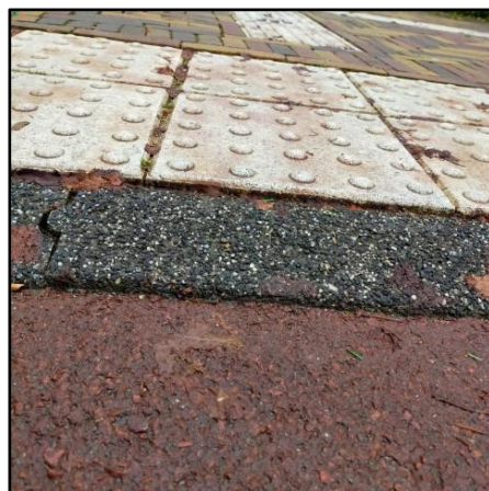
Schuine band loopt door bij de oversteek Hoogteverschil 5cm
