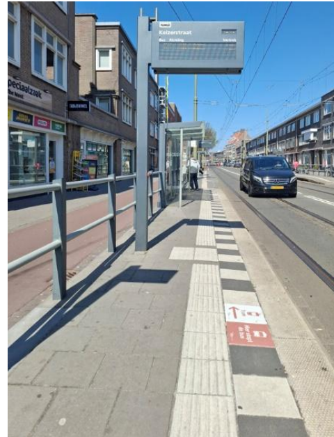
Gedeelde trambushalte met geleidelijn
