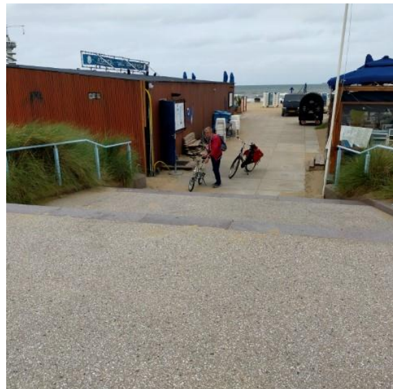
Trap zonder markering en niet herkenbaar van bovenaf
