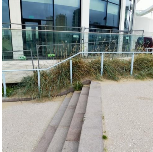
Trap zonder markering, knik van de leuning zit op de verkeerde plaats
