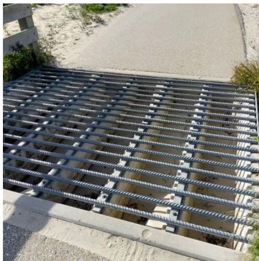
Rooster met te brede openingen
