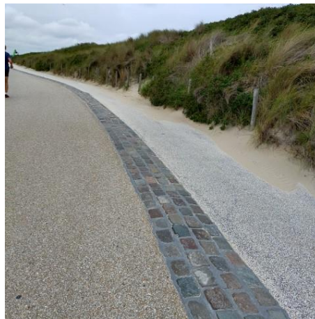
Voetpad voelbaar gescheiden van fietspad door een strook kinderkopjes
