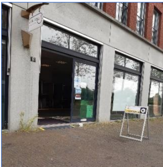
Buitenkant van het gebouw.
