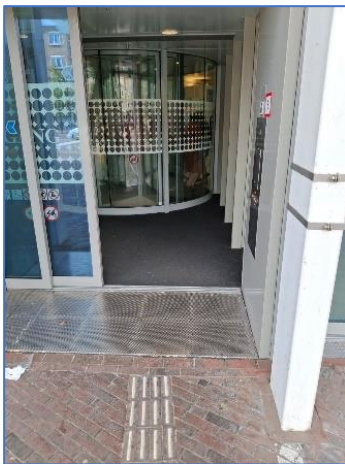
Achter de eerste voordeur ontbreekt de tijdelijke indoorgeleidelijn.
