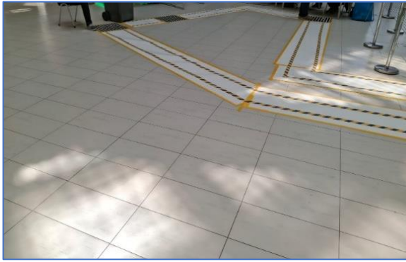
De lichtval door het dak geeft een vlekkerige ondergrond
