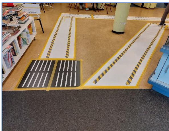
De geleidelijn start na de mat. Plaats de geleidelijn direct achter de voordeur op de mat.
