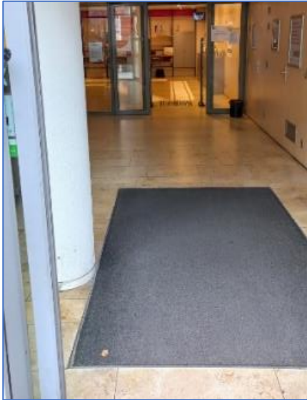
De blindegeleidelijn start niet bij de entree van het gebouw.
