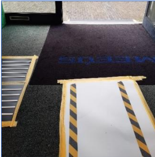
Looproute via de geleidelijn, waarbij opvalt dat de starttegel niet direct achter maar rechts van de voordeur ligt.
