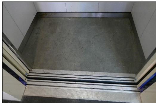
Toegang tot - en vloer van de lift
