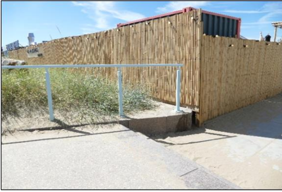
Twee maal niet goed uitgevoerde leuning wat de knikken betreft ....
