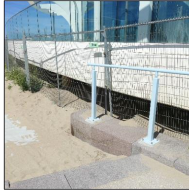
Twee maal niet goed uitgevoerde leuning wat de knikken betreft ....
