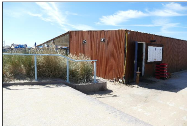
Leuning loopt goed door voorbij het ondereinde van de trap
