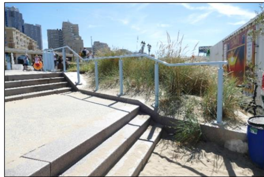
Twee maal niet goed uitgevoerde leuning wat de knikken betreft ....
