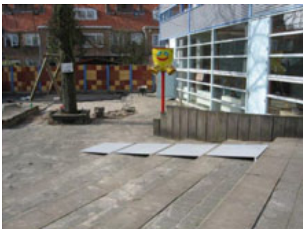
Te steile en losliggende hellingen (4 treden van 12 cm. hoog, 110 cm. lang)
