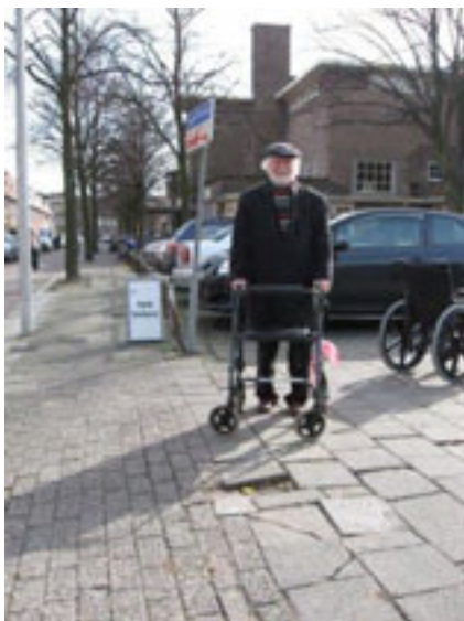
Gat in toegang naar pleintje en naar de deur; veel scheefliggende tegels.
