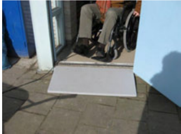
De helling zweeft en is te steil. (h: 12 cm, l: 40 cm) De aansluiting van de helling is slecht, er is een gleuf van 5 cm.
