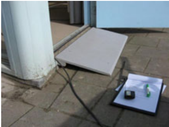
De helling zweeft en is te steil. (h: 12 cm, l: 40 cm) De aansluiting van de helling is slecht, er is een gleuf van 5 cm.
