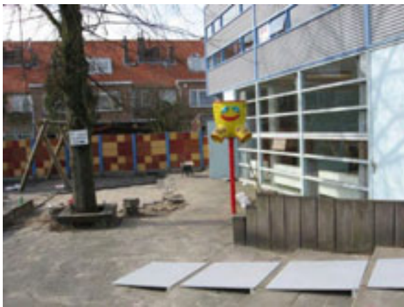
Opbreking gevaarlijk, losliggende tegels.
