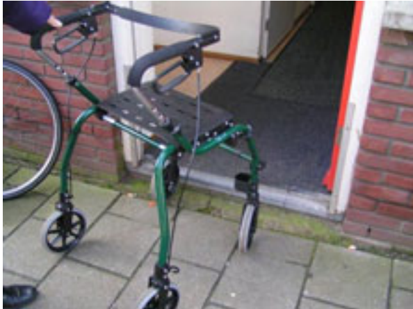
Hoge drempel (5 cm) bij ingang gebouw.
